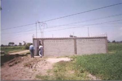
La caseta está prefabricada, de lámina Pintro-Zintro con ventilación cruzada, con acceso al frente. La caseta está montada en un patín fabricado de perfil estructural, que a su vez se instala sobre 7 topes de estacionamiento de concreto para nivelar las casetas de medición y regulación, por lo que no requieren cimentación.
