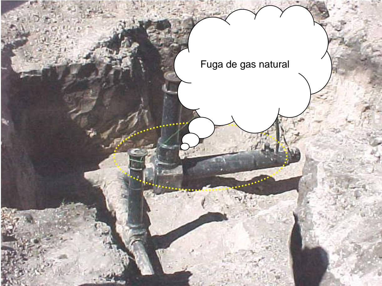
Segmento de ducto de polietileno, que resultaría golpeado por una pala mecánica en una de las calles de la Zona Industrial de la Mesa de Otay .
