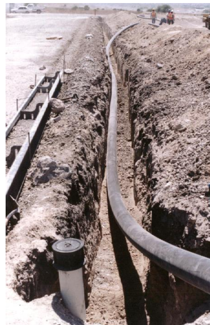
Segmento de ducto de polietileno, que resultaría golpeado por una pala mecánica en una de las calles de la Zona Industrial de la Mesa de Otay .
