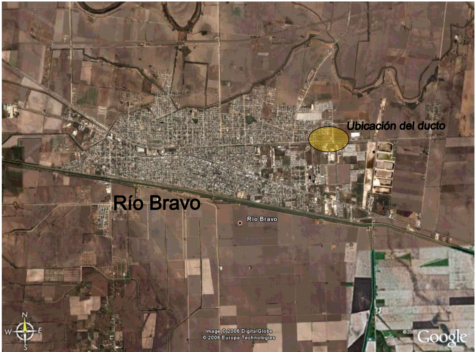
IGASAMEX BAJIO, S. DE R.L. DE C.V. Gasoducto Gruma Río Bravo Río Bravo, Tamaulipas
