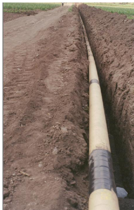
Segmento de ducto de acero, que resultaría golpeado por una pala mecánica en el Derecho de Vía del camino industrial frente a la Estación de Medición y Regulación de Proteinol , en la Zona Industrial de Apaseo El Grande .
