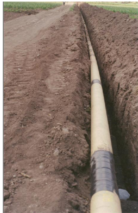
Segmento de ducto de acero, que resultaría golpeado por una pala mecánica en el Derecho de Vía del camino de terracería paralelo a la vía del ferrocarril, en la Zona Industrial de Apaseo El Grande .
