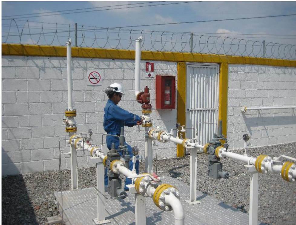
Revisa la válvula de relevo or si existe algún problema con ella.
